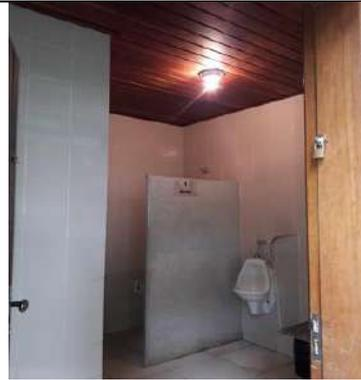
Foto 178 Padronização das luminárias existentes, eliminando lâmpadas conectadas diretamente na fiação depois
