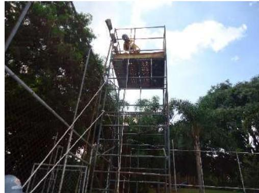
Foto 95 - Substituição das luminárias da quadra
