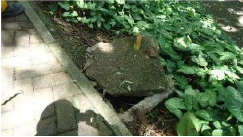
Foto 87 Tampa da caixa de passagem quebrada
