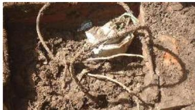
Foto 105 - Rede elétrica deteriorada
