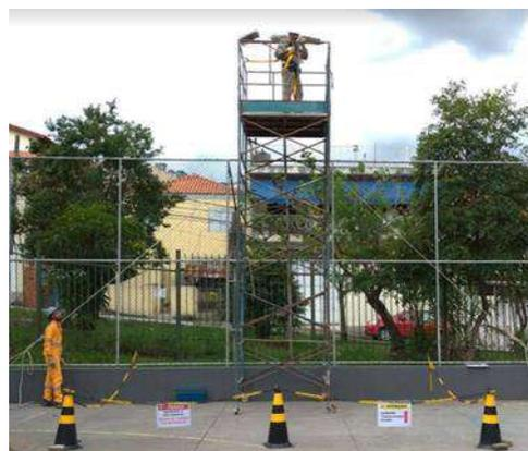
Foto 32 - Trecho em manutenção isolado e sinalizado
