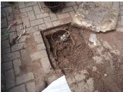
Foto 106 - Caixa de passagem deteriorada
