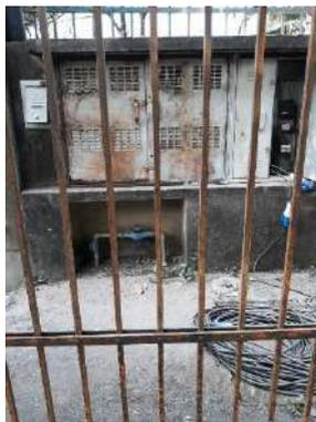
Foto 99 – Área das caixas de energia e cavalete de água de luz deteriorada
