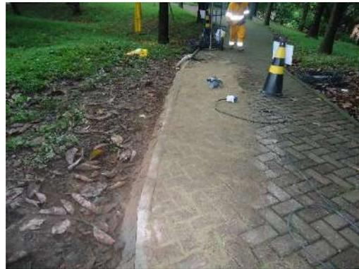
Foto 98 - Substituição de guias quebradas e nivelamento de piso
