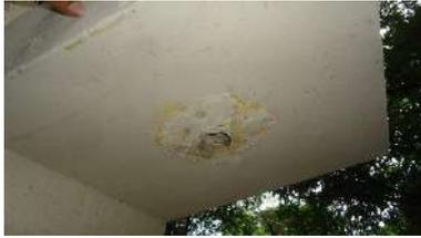
Foto 108 - Antes - Infiltrações nos telhados
